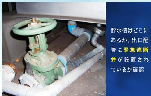
貯水槽はどこにあるか、出口配管に緊急遮断弁が設置されているか確認
