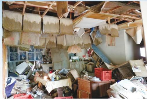
写真9 天井に達する水の跡
