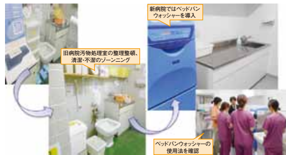
写真9. ベッドパンウォッシャーの導入
